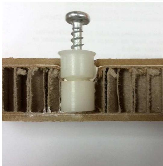
Figura 42- Posición correcta del herraje insertado
