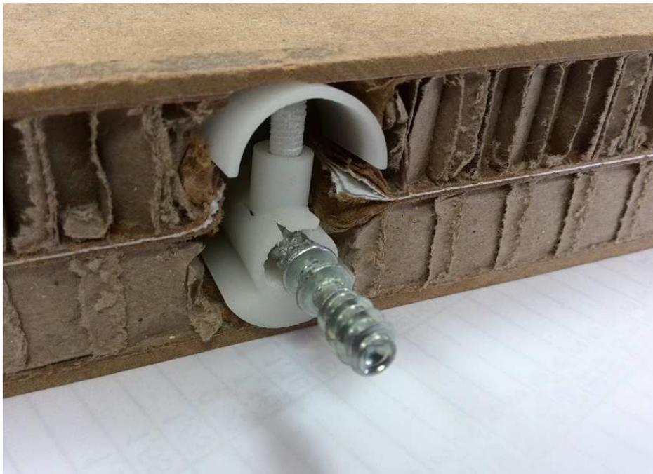
Figura 35- Inserción de excéntrica para ensamble de tableros
